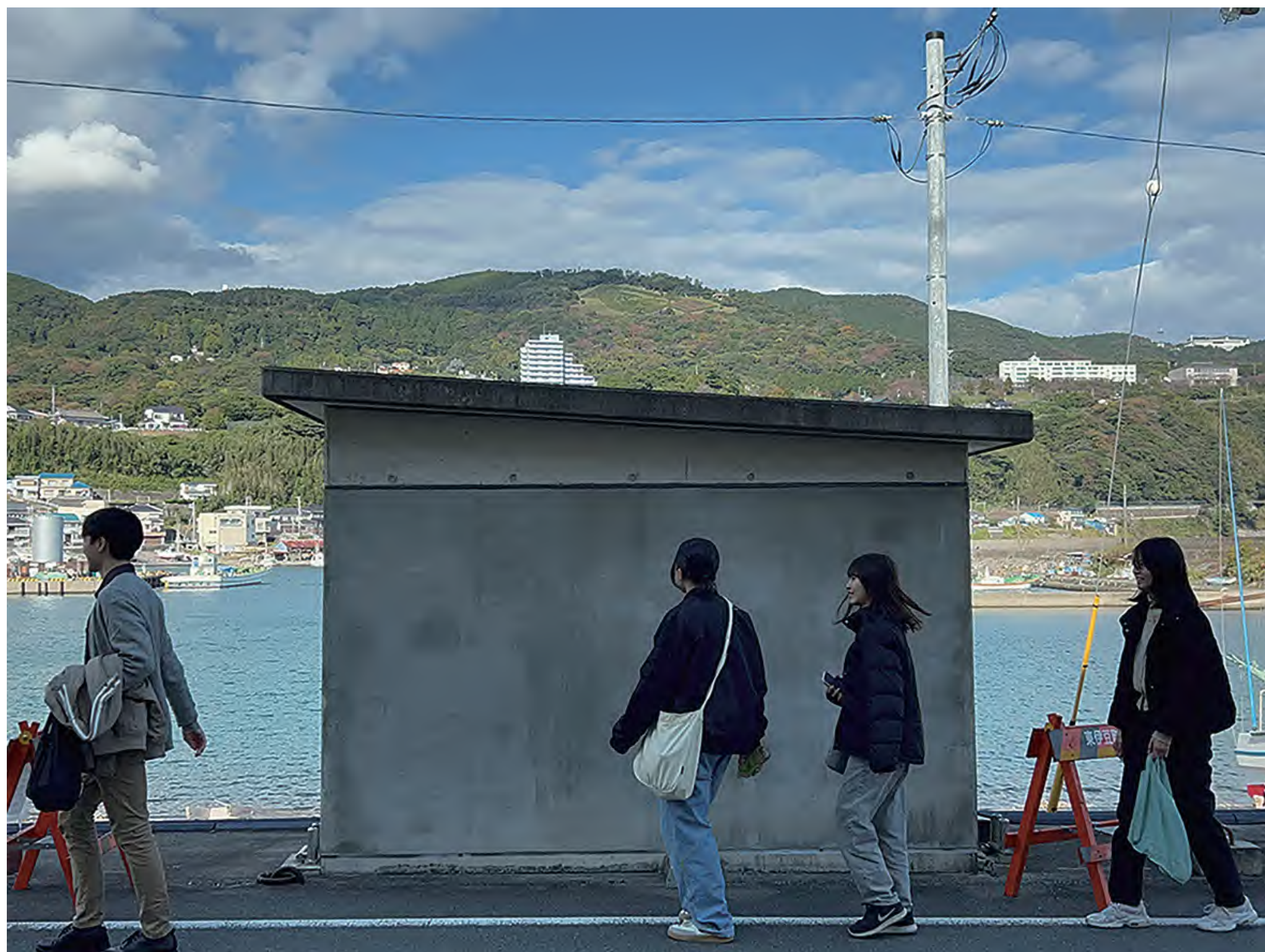
巻き上げ機のペイント前の様子
